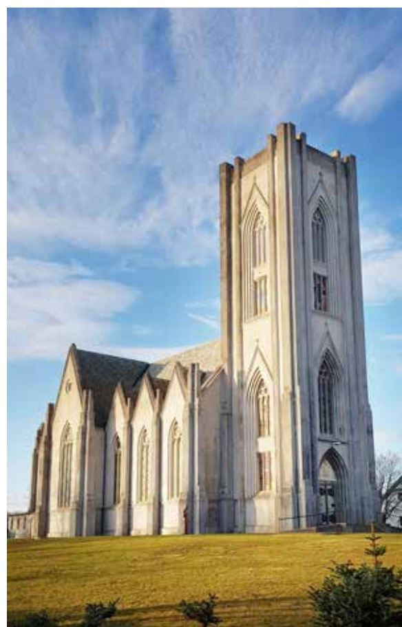
Das Dach der Kathedralekirche in Reykjavik muss saniert werden.
