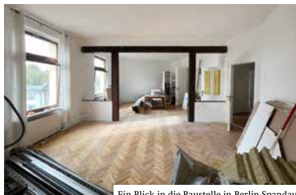
Ein Blick in die Baustelle in Berlin-Spandau.
